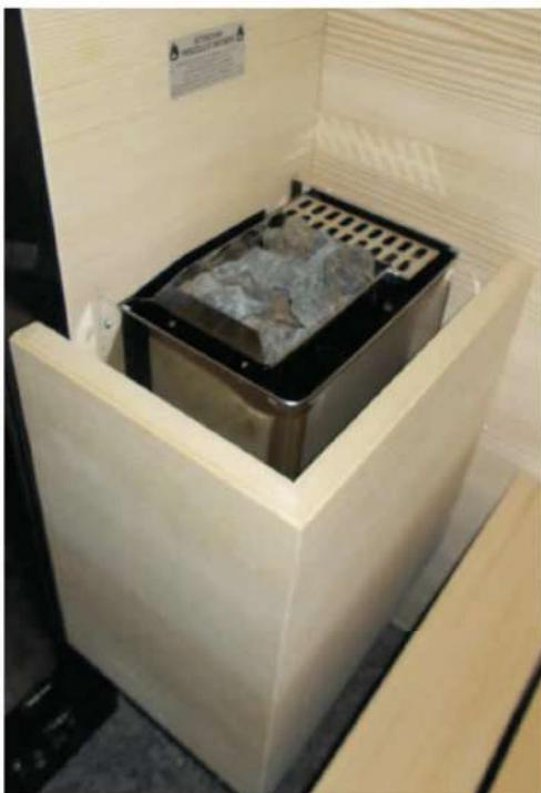
Lavare le pietre, asciugarle e appoggiarle sulla stufa fino a completa copertura delle resistenze.
