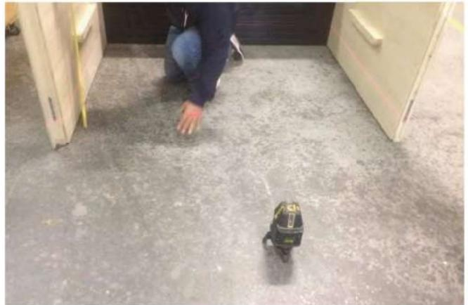
Controllare che il montaggio effettuato finora sia planare e se necessario spessorare sotto le pareti per correggere eventuali dislivelli del pavimento.
