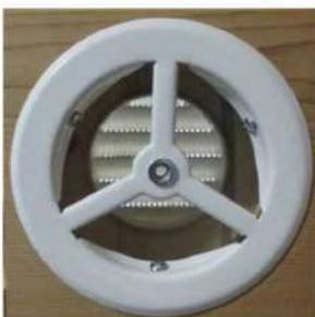
Per aumentare il ricambio aria all'interno della sauna svitare il piattello in senso antiorario. Per diminuire avvite in senso orario il piattello.
