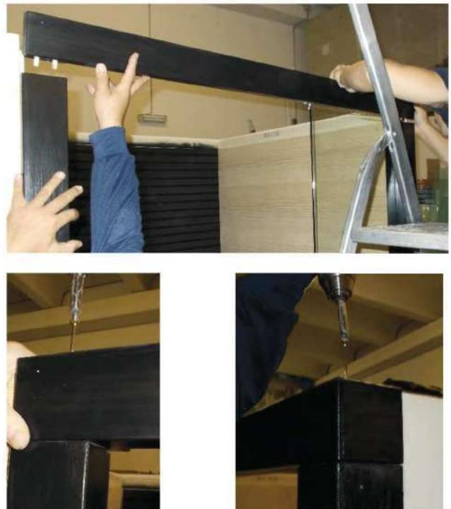
Assemblare telaio superiore facendo coincidere i pioli nei fori delle colonne.
