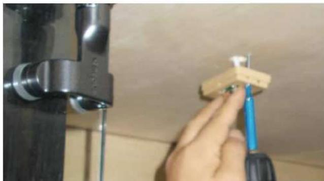
Fissare la sonda con le due viti in dotazione. Assemblare la griglietta con le due viti in dotazione.
