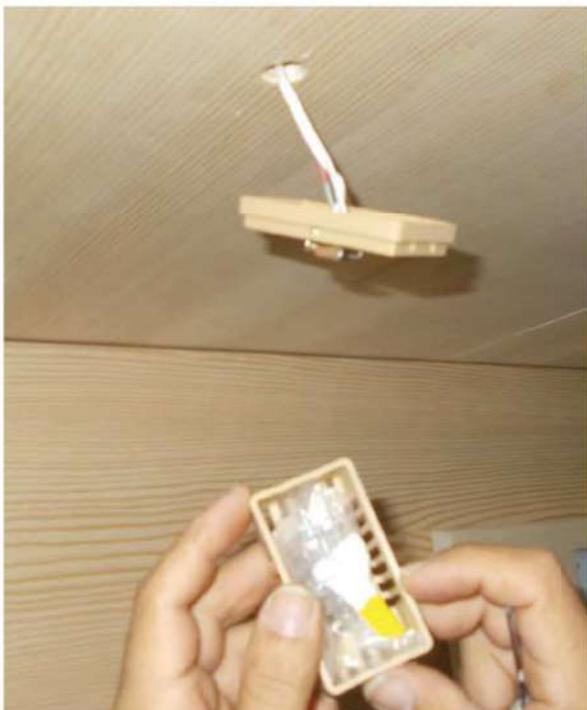
Far passare i cavi della sonda nell'apposito foro posto sul tetto nella verticale sopra la stufa.
