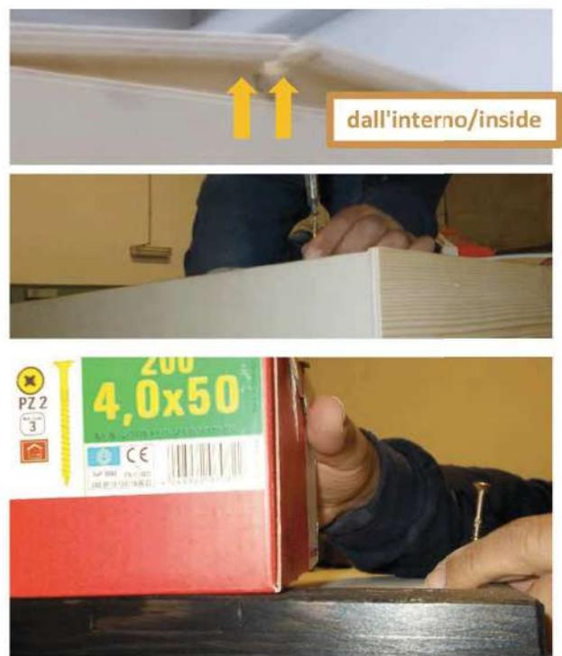
Se il tetto è composto da due parti, sollevare entrambi i tetti in prossimità della giunzione centrale per incastrare il giunto maschio/femmina. Avvitare dall'alto per bloccarlo.
