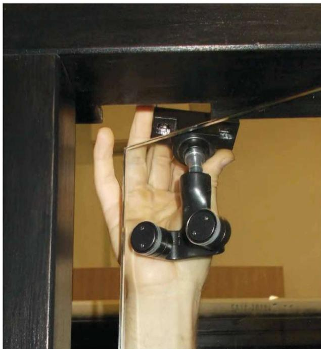
Installare la porta, avendo cura di fissare la cerniera superiore nell'apposita sede.
