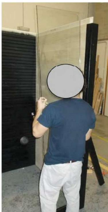
Assemblare il vetro fisso laterale inserendolo nell'apposita sede a U colonna e telaio di base.
